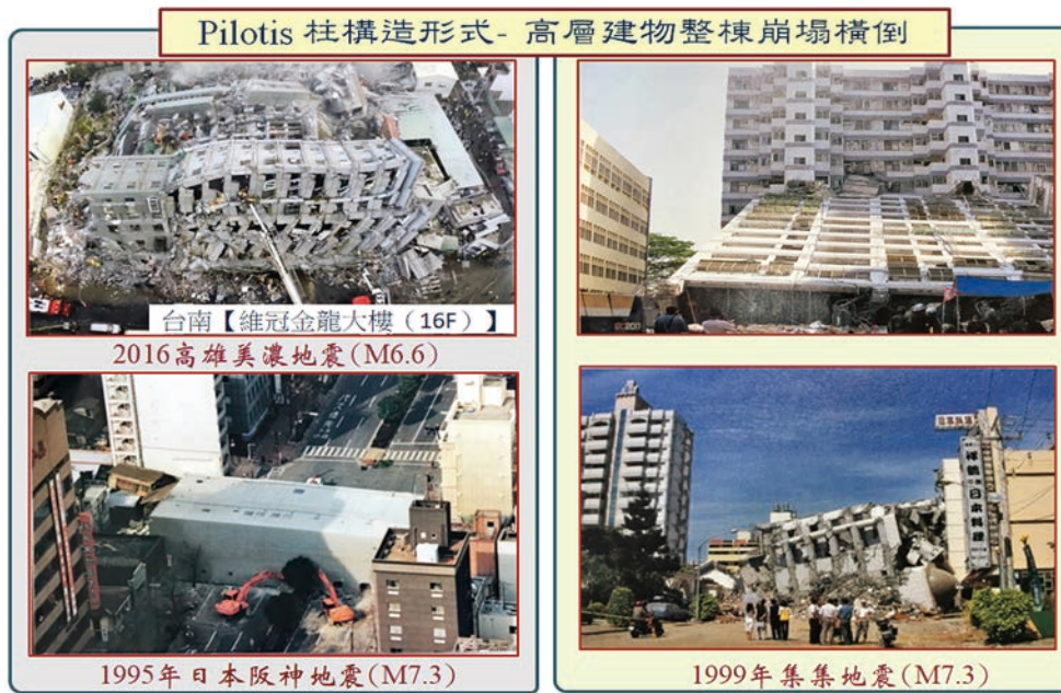
圖 8 建築物震害樣態－整棟大樓崩塌橫倒地地面 [24]
