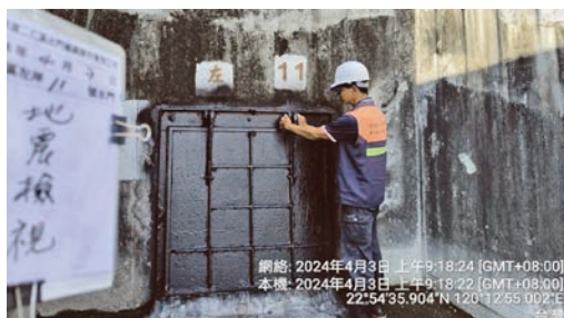
1130403 二仁溪水門檢查
