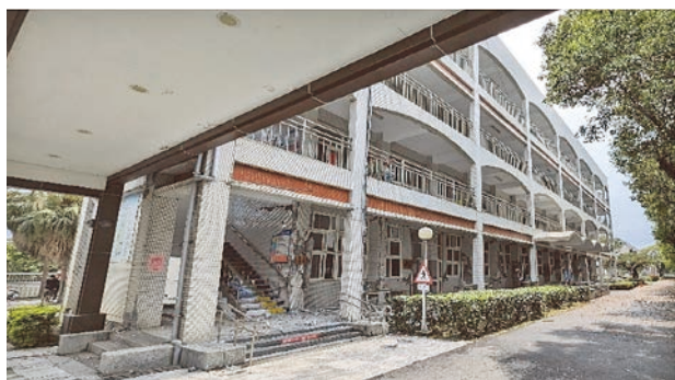
花蓮女中綜合大樓震後西側外觀
