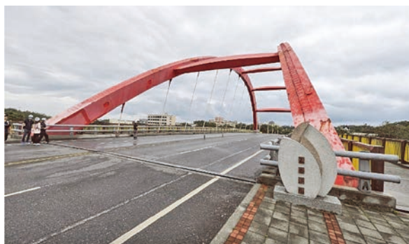
美崙溪橋震後東北側外觀
