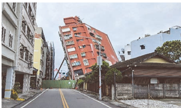
天王星大樓震後北側外觀
