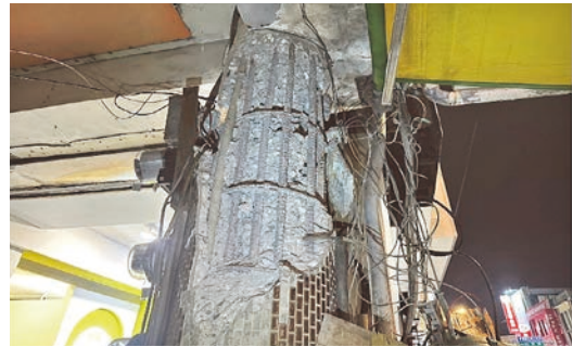
圖 67 鋼管紅茶店箍筋間距過大
