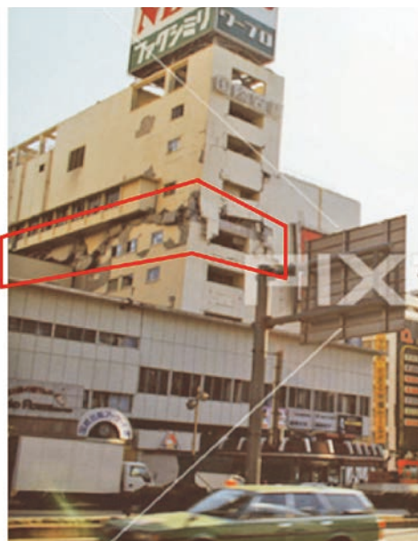
圖 3 日本 1995 年阪神地震中間弱層 （資料來源：PIXTA 圖庫資料－阪神地震）
