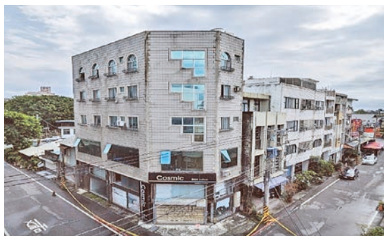
博愛街 52 號民宅震後西側外觀
