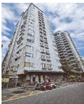
蓮花大樓震後西側外觀
