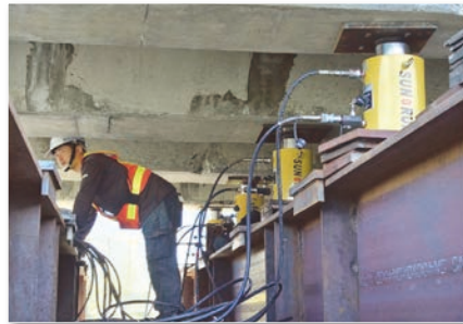
新秀姑巒溪橋緊急搶修頂升、橫移油壓千斤頂佈設
