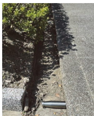
(b) 震後短向推擠距離約 515 mm
