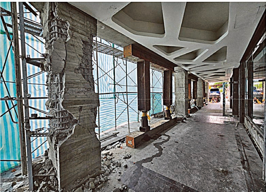
圖 84 0423 藍天麗池北側鋼構支撐
