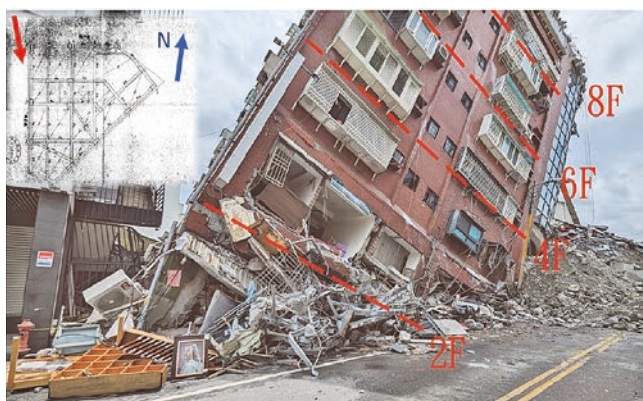
圖 7 天王星大樓南側 1F 壓碎（西北側拍攝）
