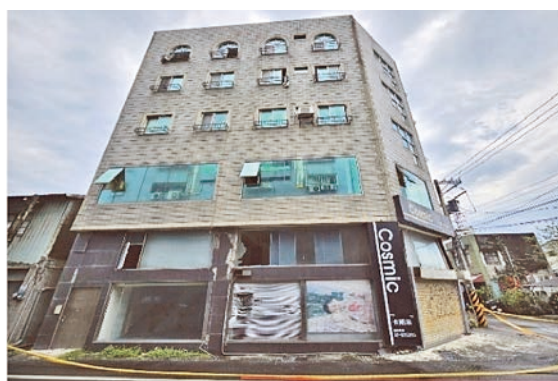
博愛街 52 號民宅震後北側外觀
