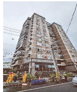
山海觀大樓震後東北側外觀
