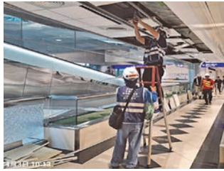
第二航廈二樓夾層受損天花板拆除
