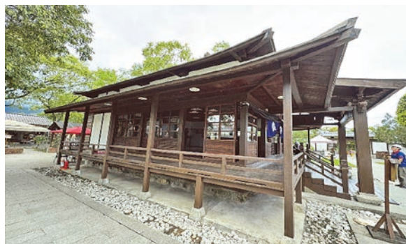
慶修院震後南側外觀
