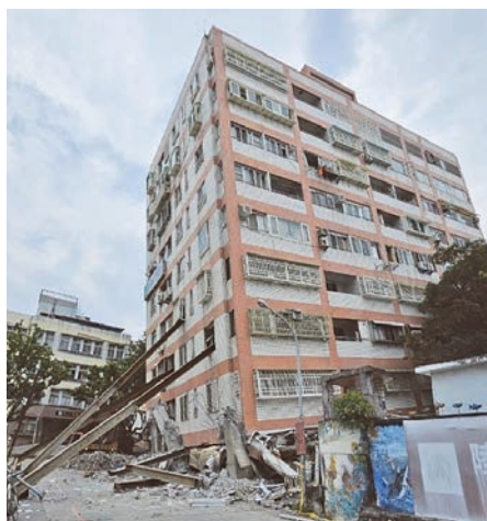
圖 102 0423 統帥花蓮大樓西側震後外觀 (攝影：林家宏)
