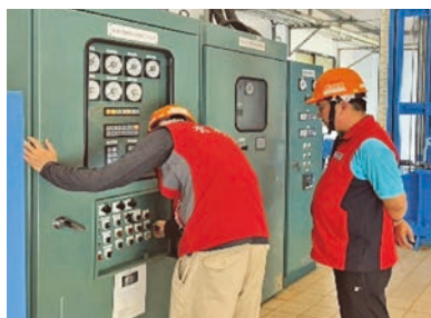
1130403 牡丹水庫閘室設備檢查
