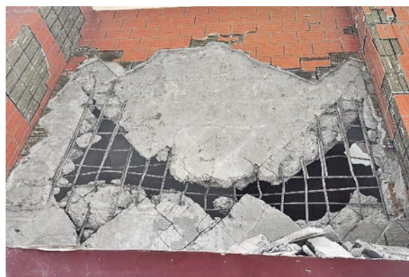
圖 43 靛邑京華梯間牆 X 型裂縫 / 剝落
