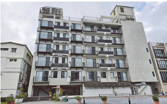
圖 15 鄰天王星大樓東南側已補強建物
