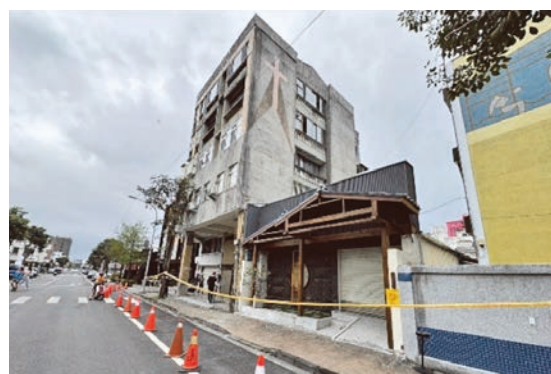
北濱街 6 號民宅震後西南側外觀
