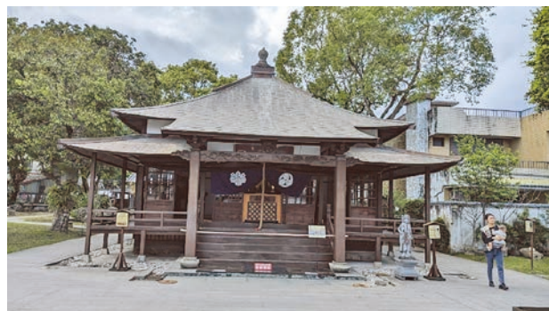
慶修院震後東南側外觀
