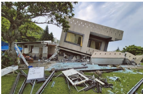
圖 95 0423 曙光假期崩塌外觀
