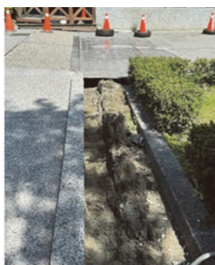
(a) 震後長向推擠距離約 320 mm
