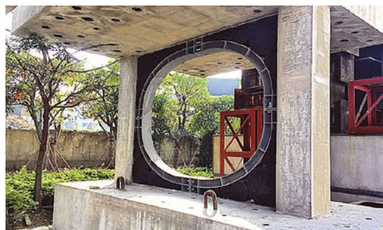
(c) 補強完工相片
